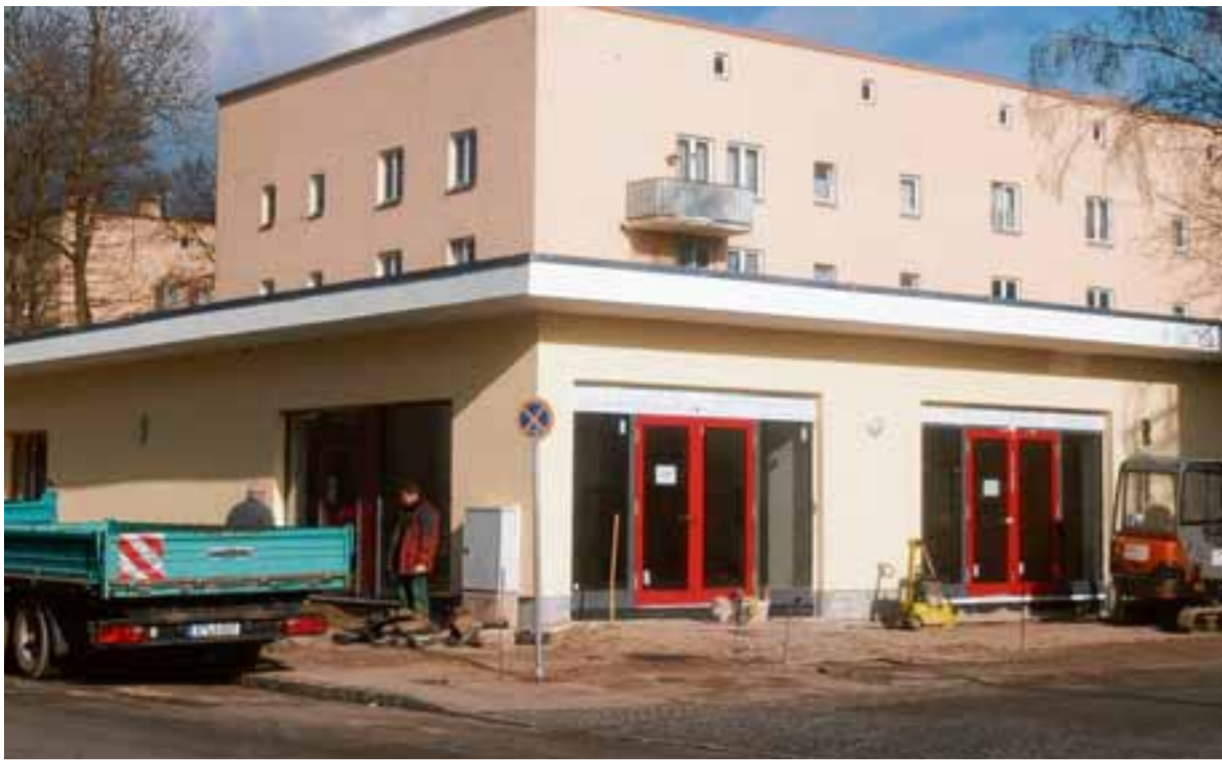
Der Mehr-Generationen-Treff in der Herrenbachstraße nähert sich seiner Fertigstellung. Noch vor zwei Wochen wurde im Inneren des ehemaligen Möbellagers von den Handwerkern gearbeitet.
